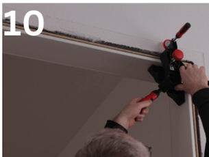
10 Setzen Sie jetzt die Zarge mit Hilfe der Gehrungs-zwingen* in der Öffnung fest
