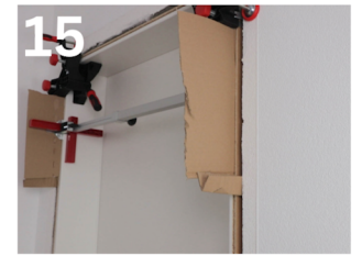
15 Stecken Sie je einen Pappstreifen der Zargenverpackung auf Höhe der Zargenspreizen in die Nut der Bekleidung
