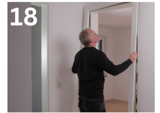
18 Stecken Sie nun die Zierbekleidung oben beginnend durch einklopfen in die Futterplatte
