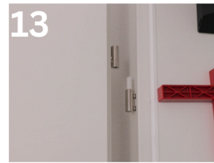
13 Drehen Sie ggf. die Bandteile etwas weiter in die Tür und hängen Sie anschließend das Türblatt ein
