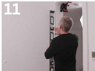
11 Richten Sie im Anschluss die Bandseite mit der langen Wasserwaage lotrecht aus
