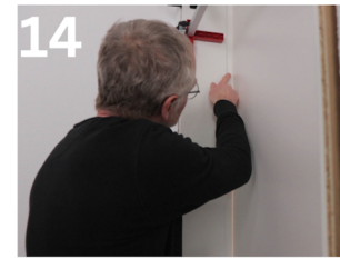
14 Richten Sie jetzt die Schließblechseite anhand des Türblattes so aus, dass sich ein gleichmäßiges Spaltmaß ergibt.
