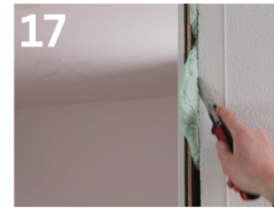
17 Schneiden Sie nach Aushärtung des Schaums (beachten Sie hier die Anleitung auf der Verpackung) den überstehenden 'Montageschaum ab
