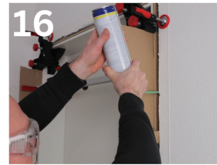
16 Anschließend können Sie den Hohlraum zwischen Zarge und Wand mit 2K Montageschaum ausfüllen (mind. 30 % der Fläche)
