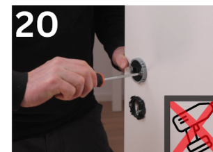
20 Befestigen Sie die Drückergarnitur nach Anleitung des Herstellers. ACHTUNG: Schrauben nicht zu fest und von Hand anziehen, da sonst die Tür beschädigt werden kann
